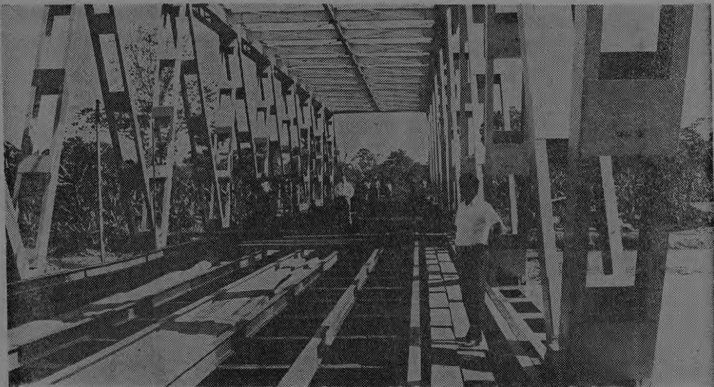
Puente de Hierro sobre el Río Pacuare. Cuando se tomó esta fotografía se elaboraba el enrejado del piso de madera de canto. Este fue saturado con un material protector para des-
